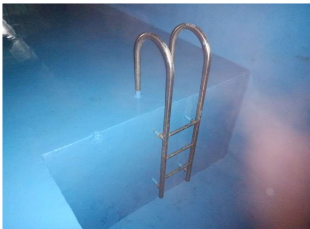
항내 집수정 진입 사다리 설치 상태양호
