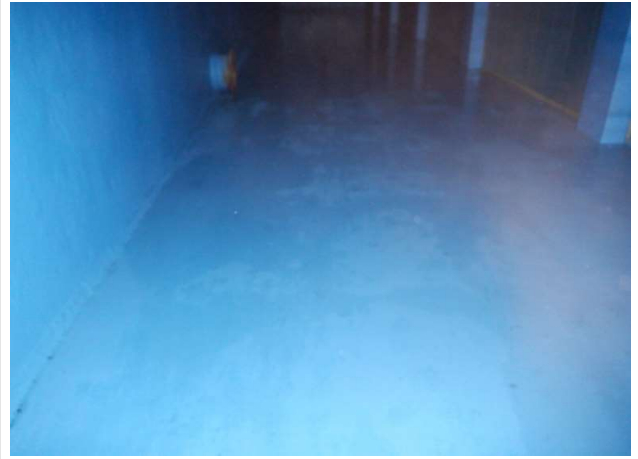
배수지2지 하부슬래브 [보수완료]
