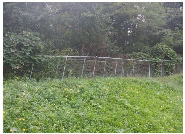
배수지 펜스 상태양호
