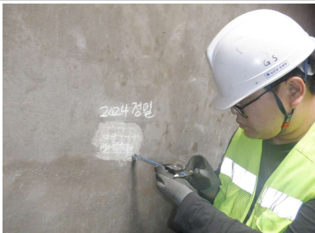
탄산화 깊이 측정
