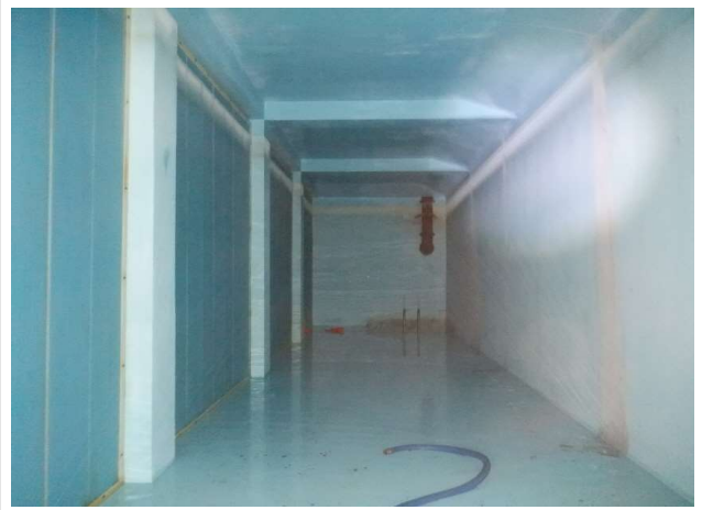
배수지 내부 전경
